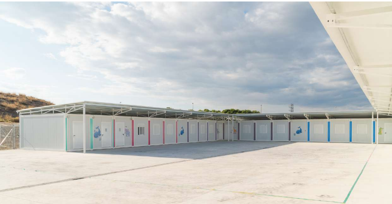
Ampliación del colegio infantil en Parque Venecia, Zaragoza
